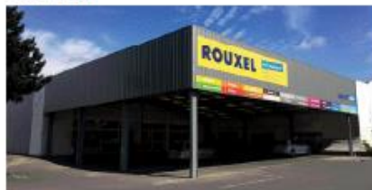
4, Rue du Houblon ZI La Pilaterie 59700 MARCQ EN BAROEUL
